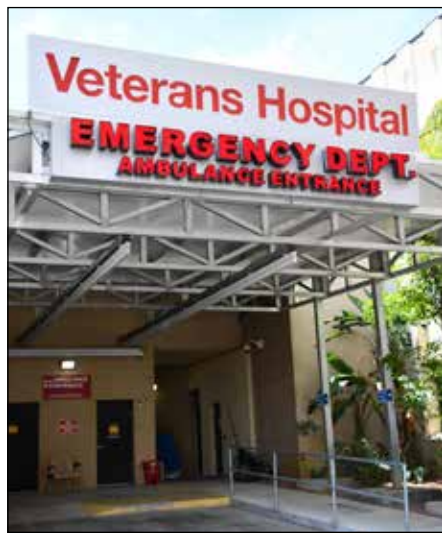
Entrada de la sala de emergencias de James A. Haley Veterans' Hospital.
